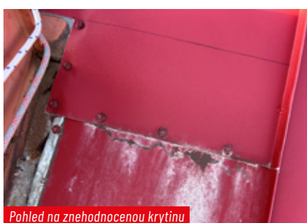
Nedokončená pokládka drážkové krytiny
