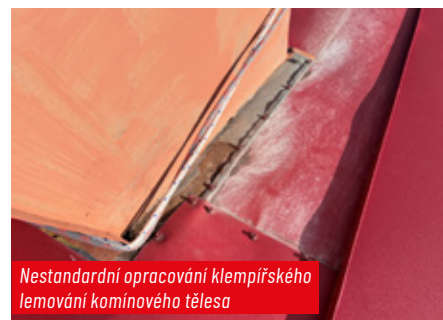
Nestandardní napojení drážkové krytiny
