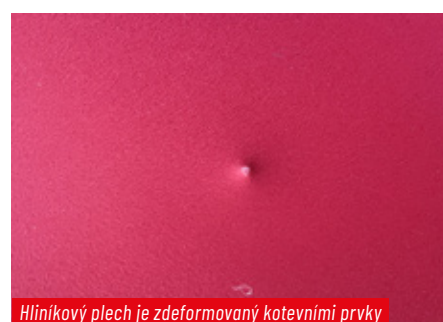
Nestandardní opracování klempířského oplechování komínového tělesa
