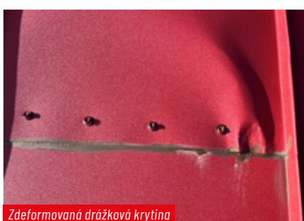
Původní hřebenáče nejsou demontovány, ale jsou zakryté novou doplňkovou hydroizolační vrstvou
