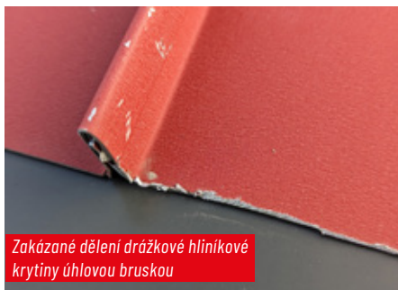
Nestandardní napojení drážkové krytiny
