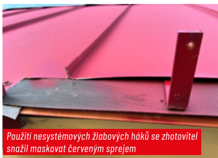
Zakázané dělení drážkové hliníkové krytiny úhlovou bruskou
