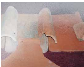
Obr. 2 - Ukázka pokládky římské krytiny
