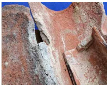
Obr. 4 - Zámek na ručně vyráběné krytině
